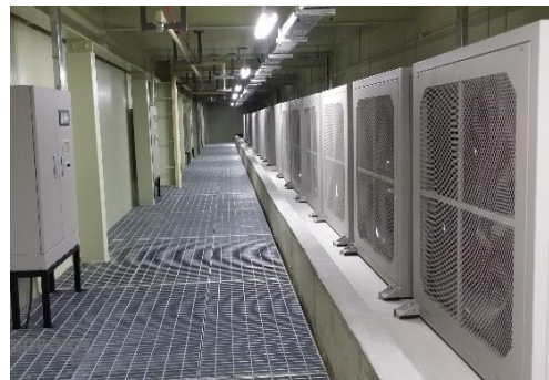
“K사” CDC 모듈형 Built up 시공
