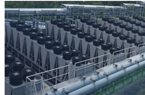
“S사” IT센터 일체형Chiller 설치
