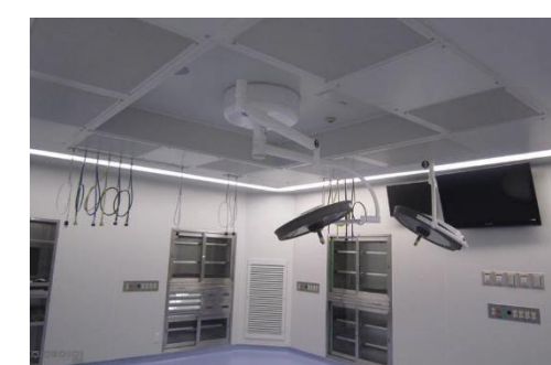
“S병원” 저체온수술실 공사
